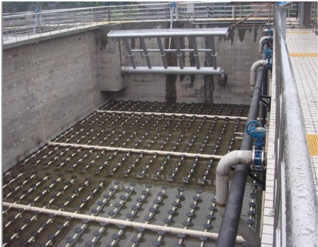
Рисунок 2.3 – Розташування пристроїв, що реалізують подачу повітря в аеротенк
