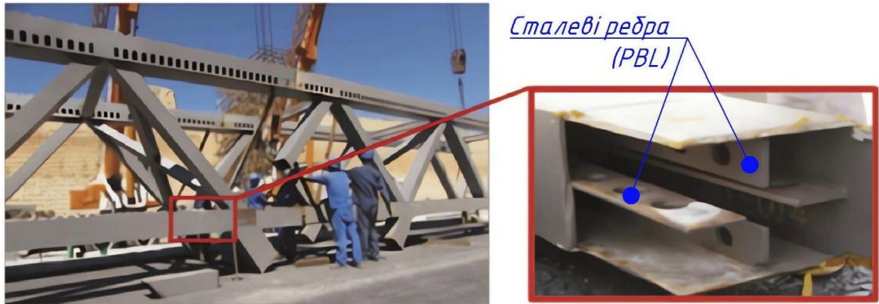
Рисунок 1.6 – Застосування посилення ребрами PBL в прямокутних трубобетонних елементах мосту
