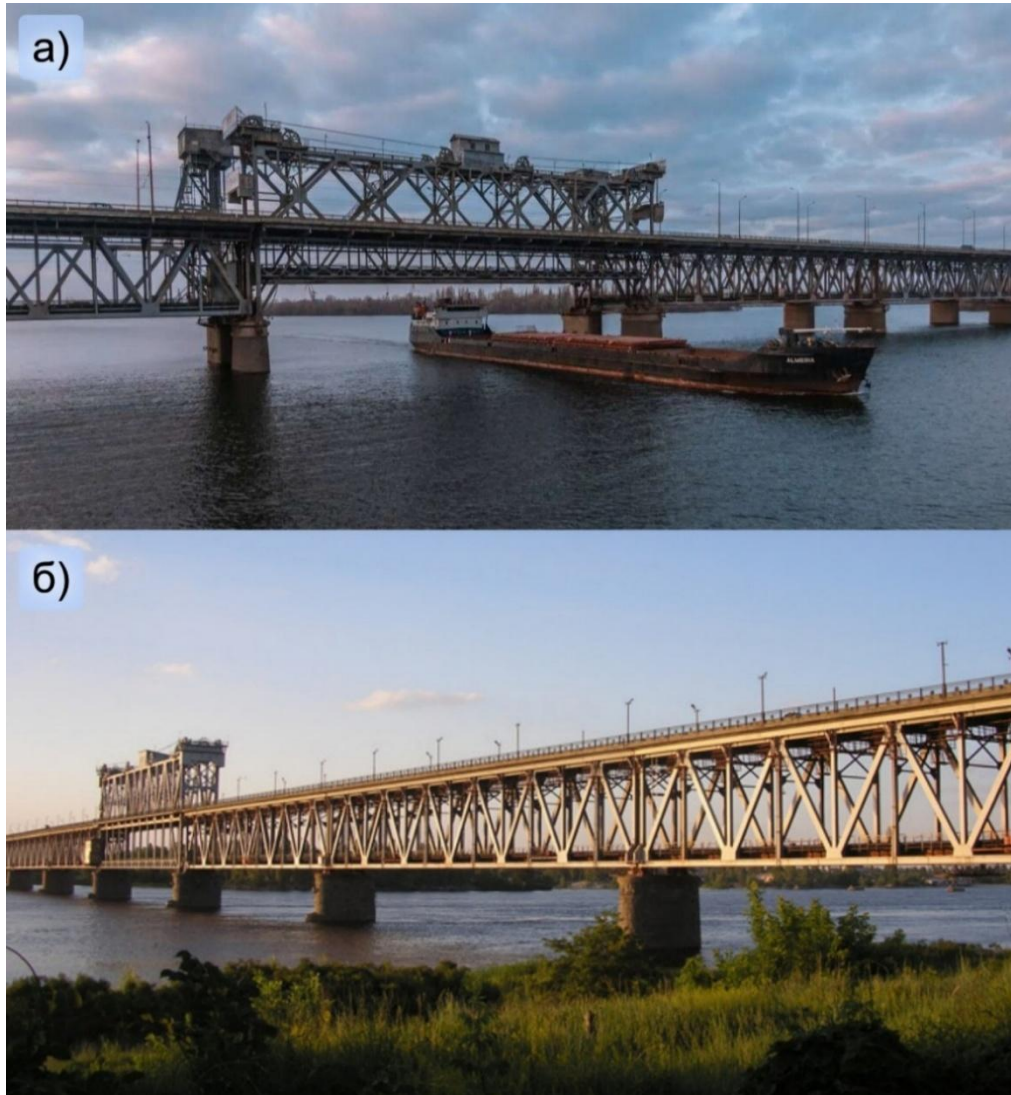
Рисунок 1.12 – Ферменні мости з їздою поверху: а – Амурський міст [33]; б – Крюківський міст [34]
